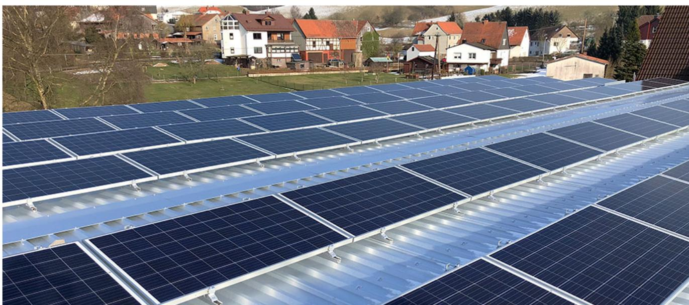
Nach der Dachsanierung wurde die PV-Anlage mit dem S-Dome Small System errichtet (Quelle: Solar Sky GmbH).
